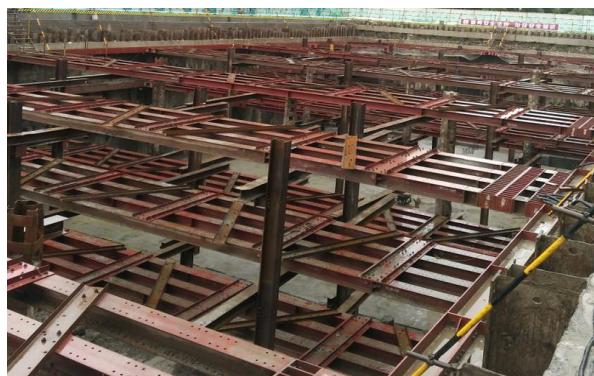
图 10 支护结构现场照片
