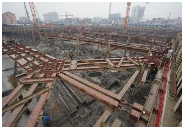
图 2 H 型钢支护体系现场照片
