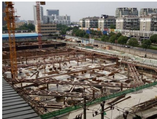
图 4 支护结构现场照片
