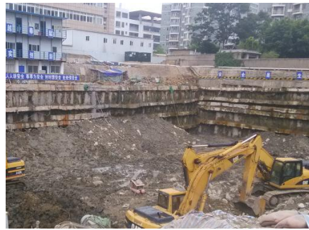
图4 坑内土方回填
