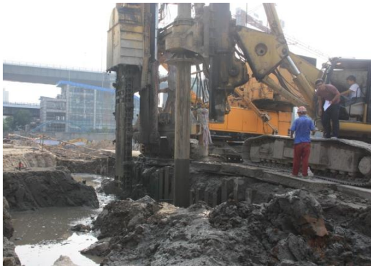
图5 TRD 与旋挖机联合施工
