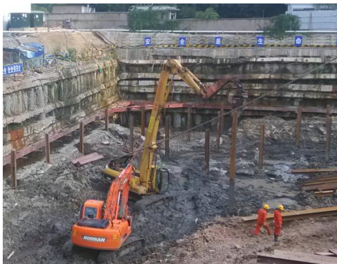
图7 型钢立柱施工
