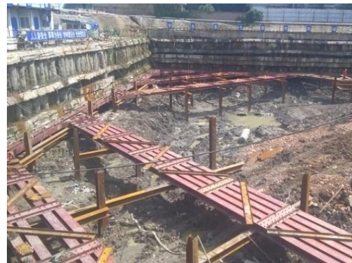
图8 预应力型钢组合支撑现场施工
