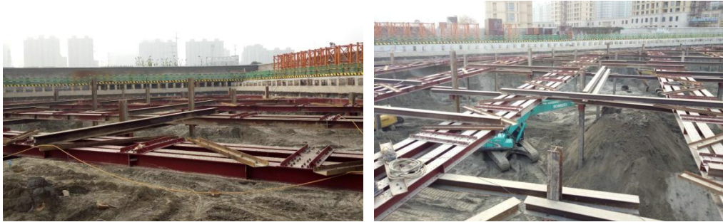
(a) 支撑安装
