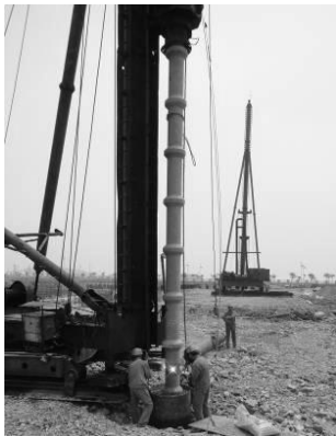
(a) 锤击法施工过程
