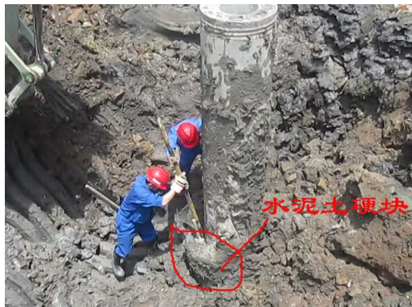
图7 S5桩现场开挖情况
