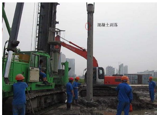
图2 有缺陷模型桩沉桩现场
