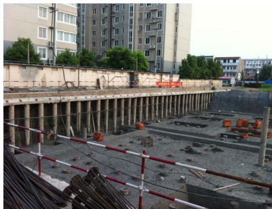
图 4 基坑开挖后的效果
