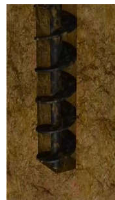
步骤 3 下放钻头钻孔
