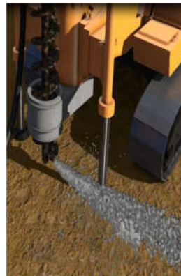
步骤 2 地面旋喷测试
