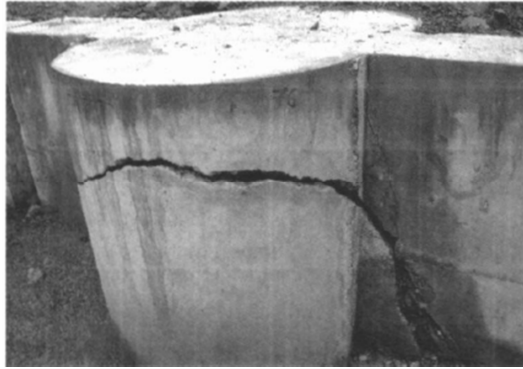
图4 抗滑桩裂缝
