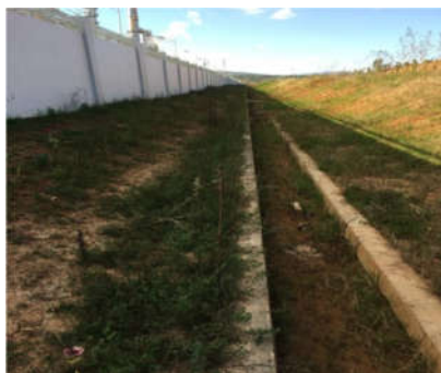
图3 厂区排水明渠
