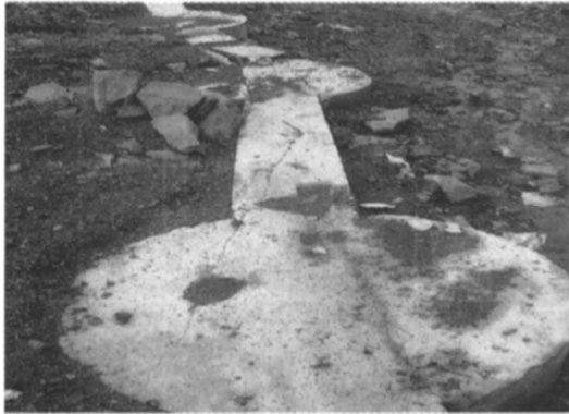
图5 挡板裂缝
