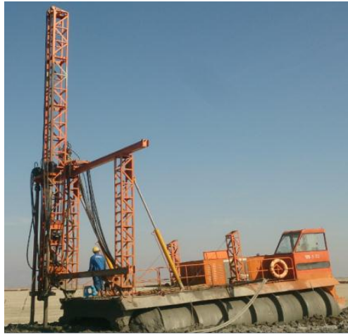
图3 固化现场施工
