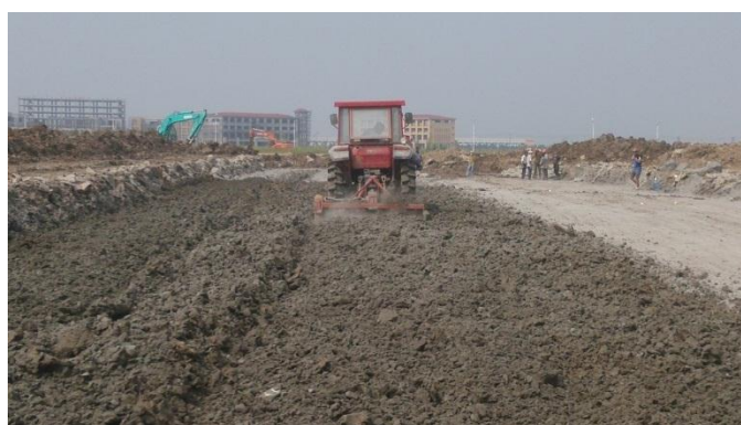
图3 旋耕机匀拌
