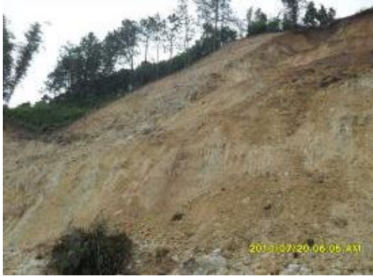
图 1 开挖边坡与滑坡正面
