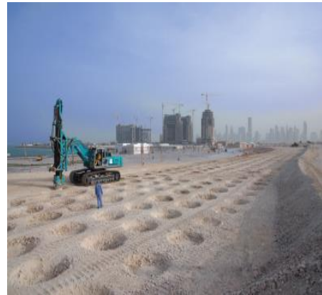
图 7 多哈体积填料的压实
