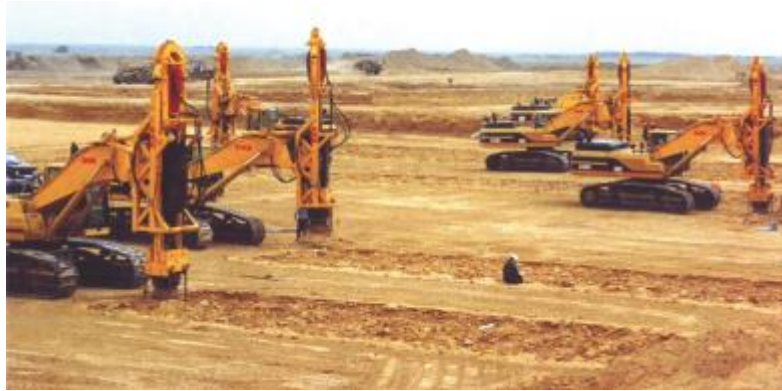
图 13 哈萨克斯坦黄土砂的压密
