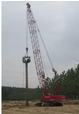
图8 现场施工设备
