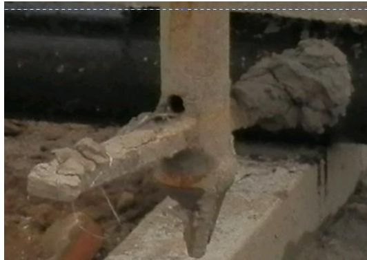
图5 A、B区搅拌设备的喷浆口和叶片
