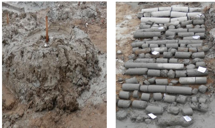
图 7 A 区桩顶冒浆及桩身芯样图
