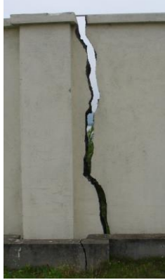
图1 围墙开裂
