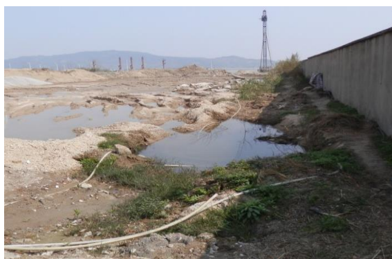
图9 现场输浆管较长情景
