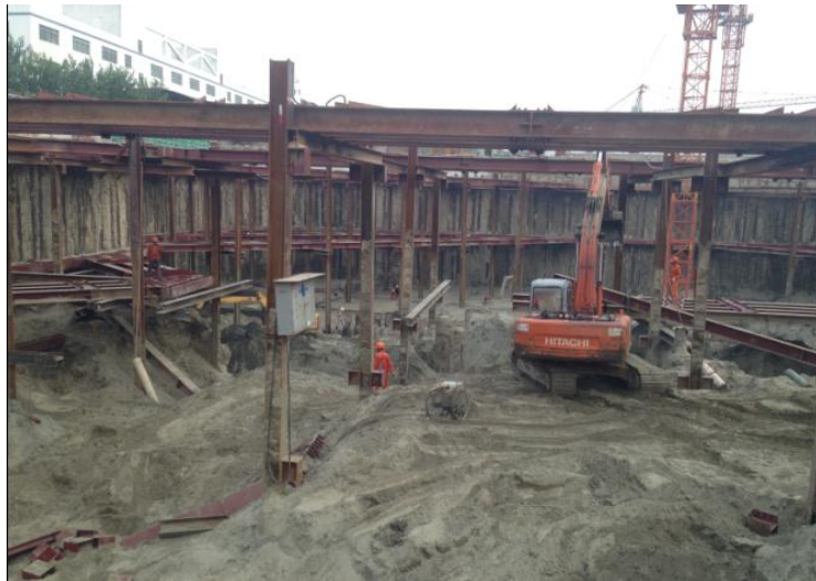
图4 盆式开挖现场照片
