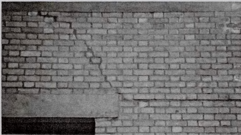
b 地基加固托换后裂缝闭合恢复原貌实况
