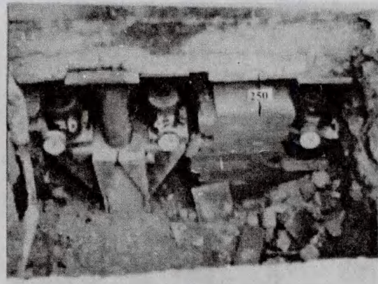
b 取出顶升千斤顶塞入托换钢管托换完毕顶升量达 250mm 实况
