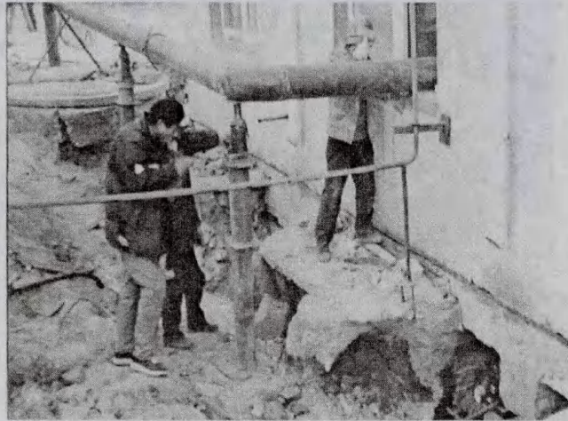
图 11 用钢管垫墩做立柱支顶，千斤顶施压控制上升高度
