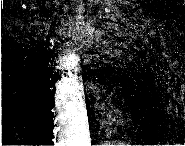
图7 机修车间西北角处地下管道接头腐化破裂严重跑水实况
