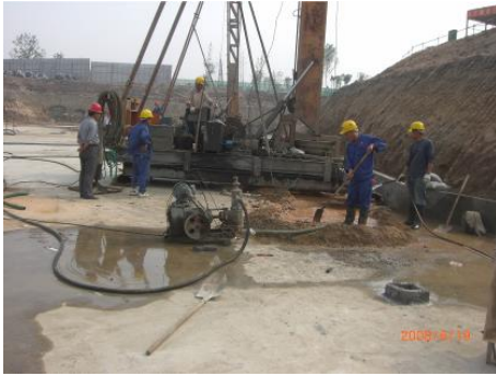
图 8 A 组锚杆施工实景
