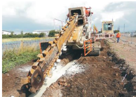
图4 (a) 沟槽搅拌系统设备
