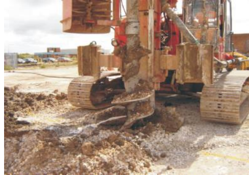
图 5 2007 年桑顿工程现场采用 SMT 的化学氧化法
