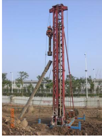
图 3 变截面劲性旋喷搅拌桩施工设备实物照片
