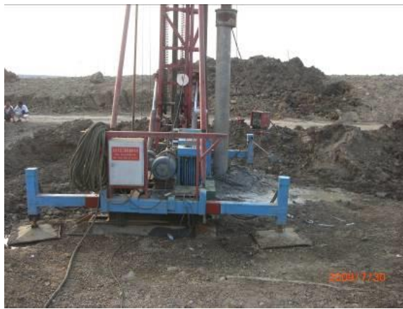
图7 芯材插入工艺试验照片
