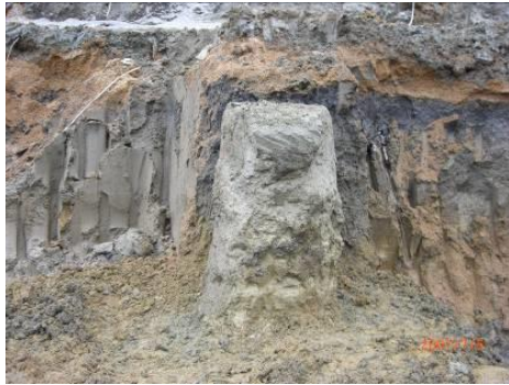
(a) 采用图 4 (a) 钻头的试桩情况
