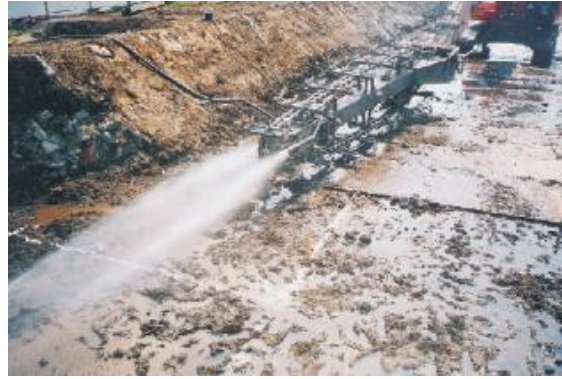
图3 (b) 电动搅拌系统中高压泥浆输送设备
