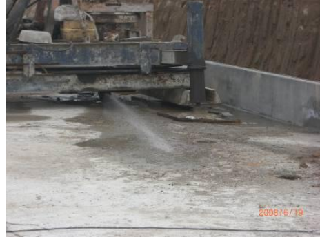
图 9 B、C 组锚杆施工实景
