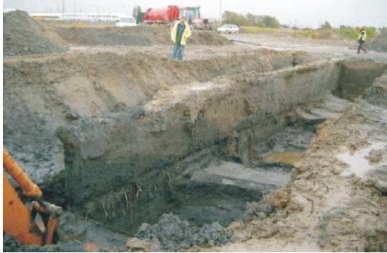
图 4 (c) 沟槽搅拌系统成槽结果
