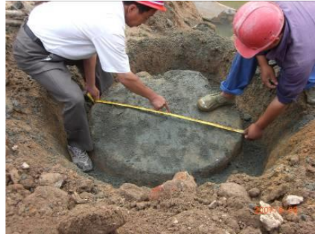
(b) 采用图 4 (b) 钻头的试桩情况
