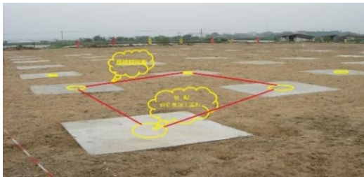
图 15 大直径刚性复合疏桩桩顶桩帽盖板
