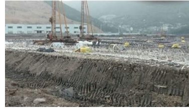
图9 环保型高能量高渗透秸秆降解大孔径排水真空预压后的现场图
