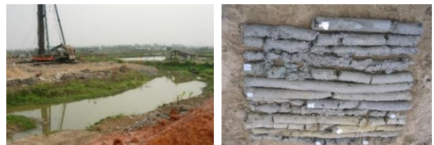
图 13 深厚软基原位、原貌地质现场及土样
