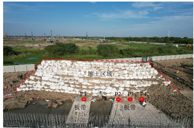
图 4 堆载试验 II 现场堆载试验测试照片 Fig. 4 Loading test for test No. 2
