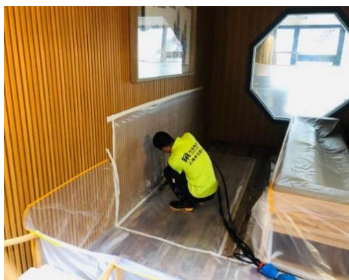
图8 室内注浆施工图
