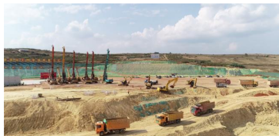
图 8 土石方现场施工照片
