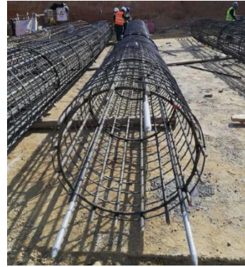
图6 桩端注浆孔
