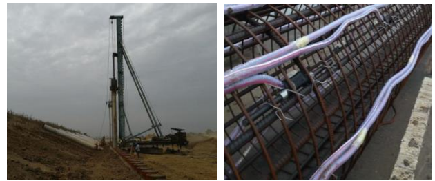
(a) 桩基施工
