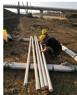
(c) 测斜管连接和埋设
