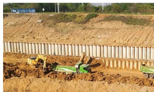
(d) 渠道内土体开挖
