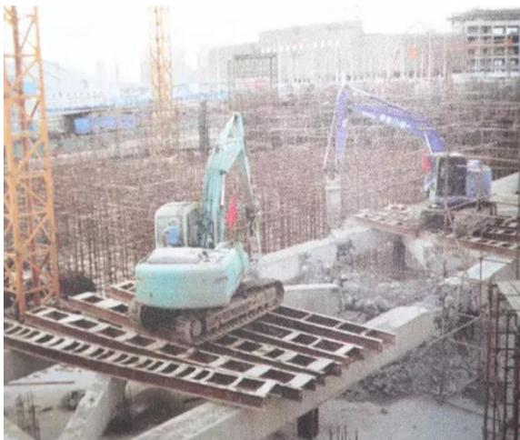
图 2 钢筋混凝土支撑拆除作业
