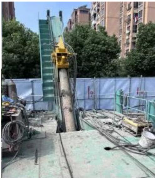
图 18 斜向钻进高压旋喷桩
