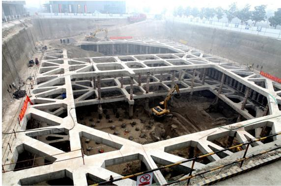
图 1 传统钢筋混凝土支撑
