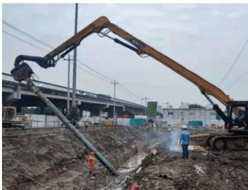
图 19 打设斜撑钢管
