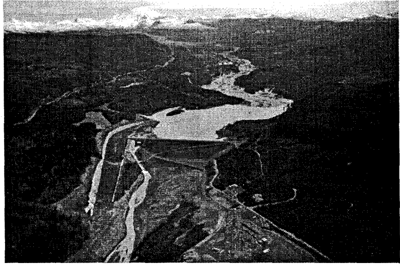
图6 竣工后的圣劳伦斯泥沙蓄挡坝的鸟瞰图
