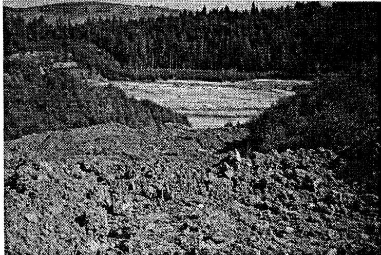
图10 圣劳伦斯泥沙蓄挡坝左岸坝肩挖出的冰渍砂砾层的不稳定土堆
