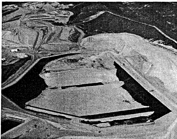
图2 1988年三月危险废弃物堆失稳前 Kettleman 山区 B-19 单元 I-A 区块的斜视图
