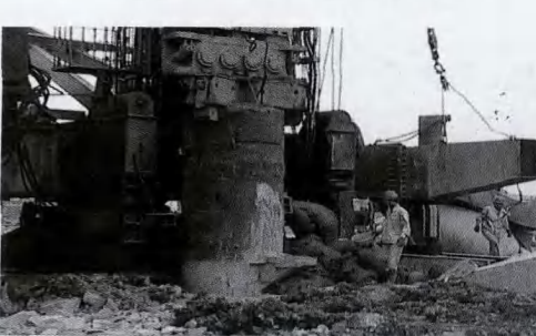
宁波商会大厦基坑支护
