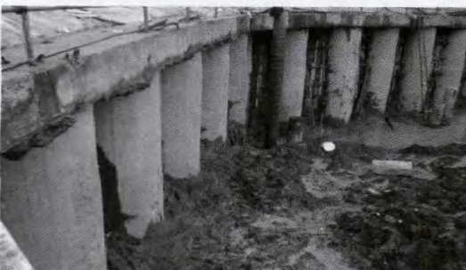
福建漳州阳光都市酒店基坑支护
