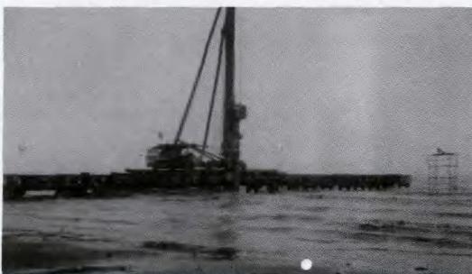
上海金山卫筒桩疏导堤现场施工
