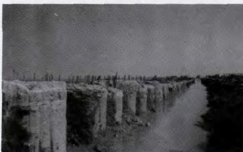
上海金山卫联体筒桩疏导堤
