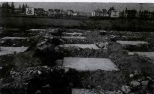
杭宁高速公路桥头软基处理
