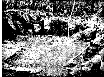
图4 雨水泵房渗水流砂示意图
