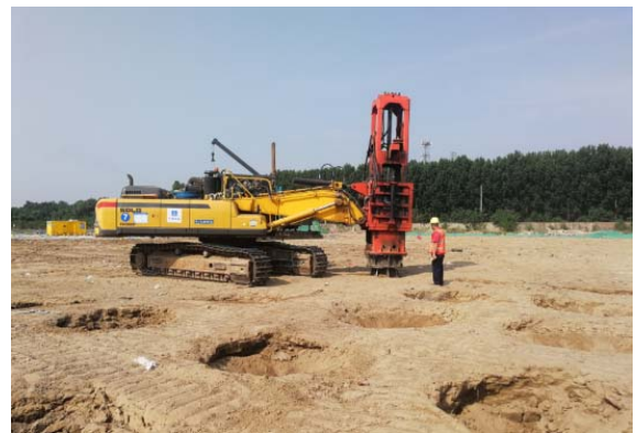
图 4 150 kJ 超重型液压夯现场试验
