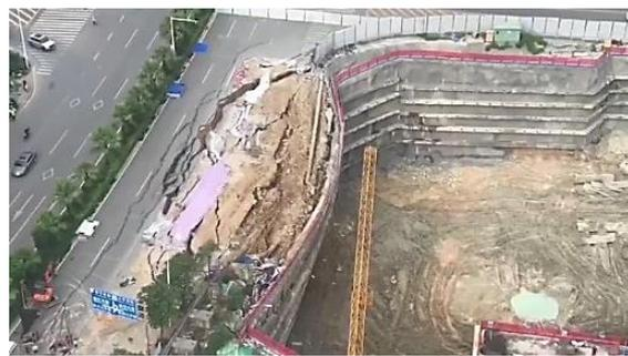
图3 正在倾倒中的坑体
