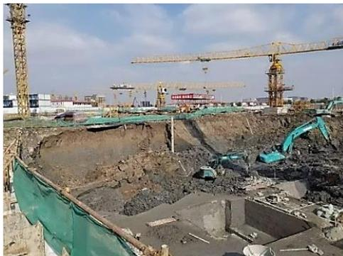
图2 基坑坍塌、土方滑坡示意图
