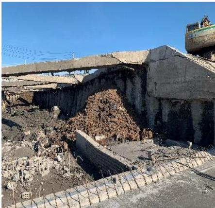
图4 基坑支护折断
