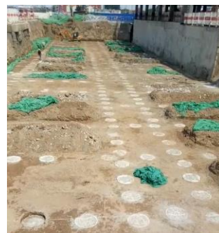
图 4 桩间土清理、桩头凿平
