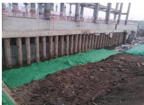
图 3 支护桩清理后作为 CFG 桩的位置图
