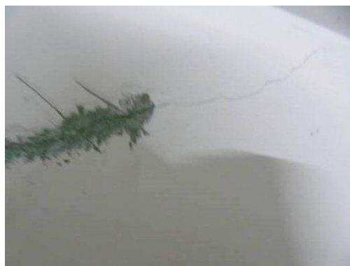
图3 填充墙开裂
