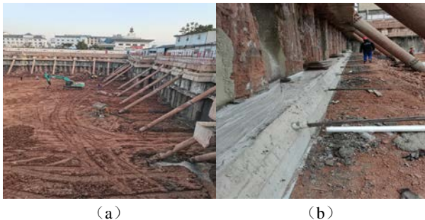
图7 基坑加固后效果图
