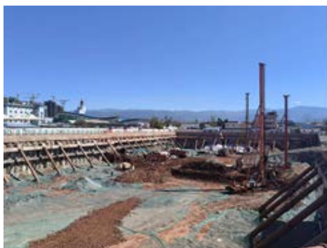
图 1 基坑现场照片
