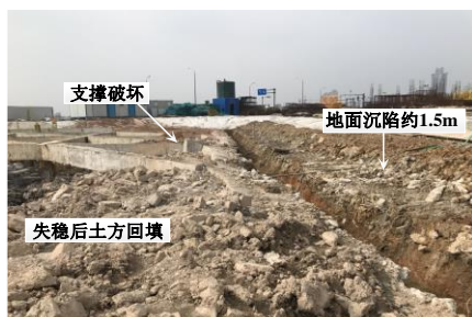
图 3 失稳后支撑体系破坏
