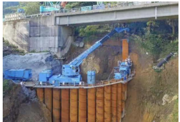
图6 大桥基础的钢管桩抢险修复工程
