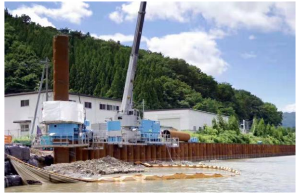
图5 河流护岸的钢管桩抢险修复工程
