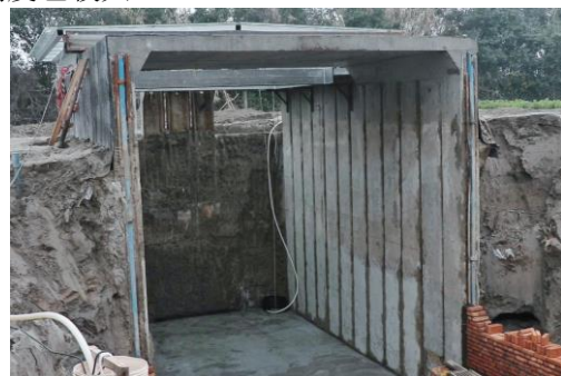
图 6 TAD 墙现场试验照片
