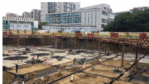
图7 交错叠合型钢支撑现场图
