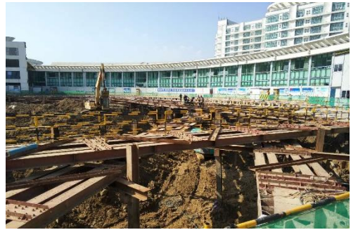
图5 交错叠合预应力型钢支撑现场安装图
