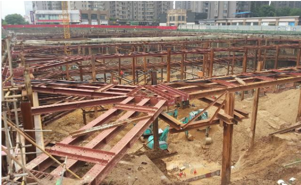
图1 预应力型钢支撑体系
