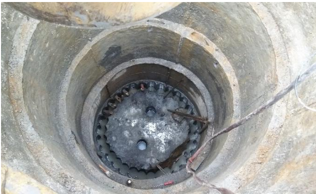
图 1 桩底微风化基岩水钻施工
