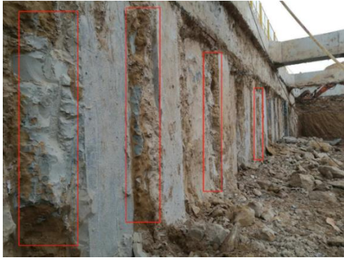
图 11 截水帷幕施工后开挖桩间咬合情况
