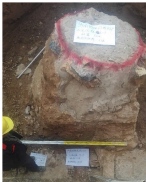
图10 DJP工法成桩效果开挖检测
