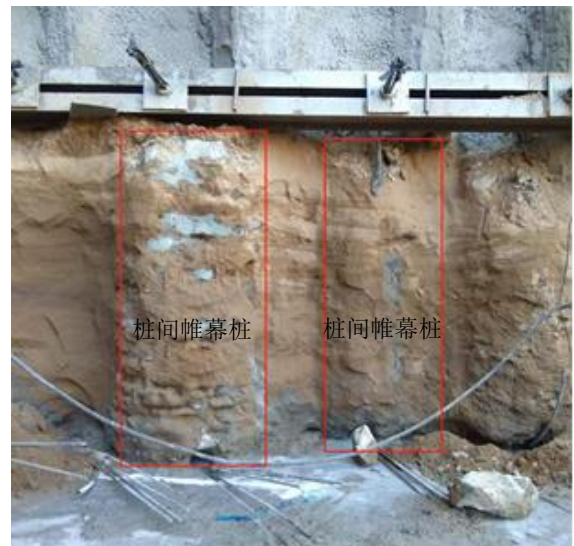
图 18 桩间 DJP 截水帷幕桩开挖效果图
