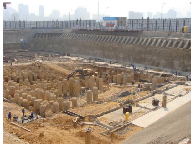
图 8 DJP 截水帷幕桩施工后开挖至基底现场照片
