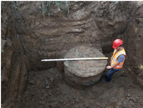
图 14 试桩开挖效果
