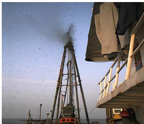
(b) 杭州湾大桥勘探浅层气喷发
