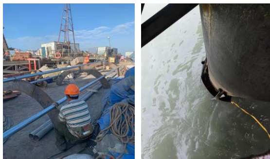
图 8 导向装置制作及安装图
