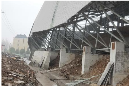
图2 基础与网架变形照片
