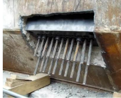
图3 位于刃脚下的钢绞线
