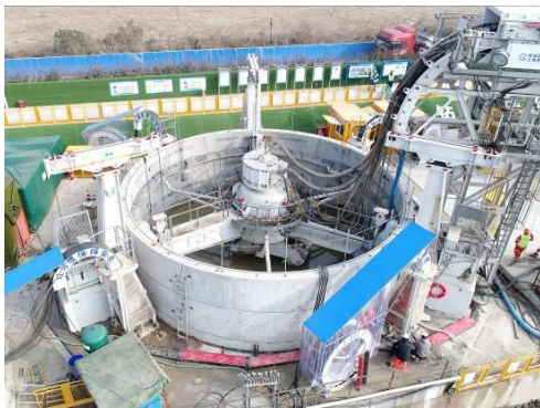
(a) VSM 设备主机安装
