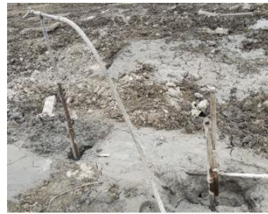
图 5 补救注浆施工
