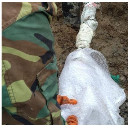
图 3 注浆器隔离止浆段做法
