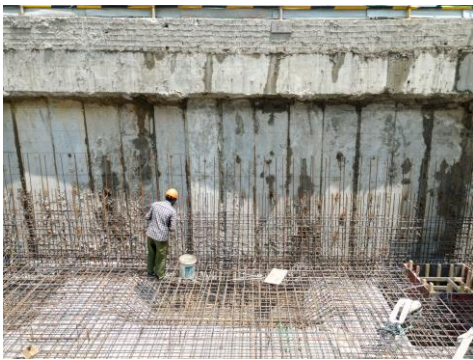
图8 开挖后装配式连续墙照片
