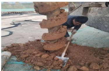
(b) 下部长螺旋干作业成孔
