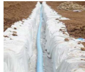
(a) 铺设透水管
