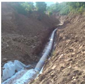
图 4 铺设中的上游主盲沟主体涵管
