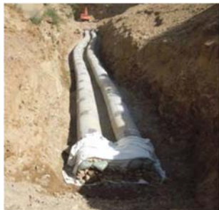
图 5 铺设中的下游主盲沟主体涵管
