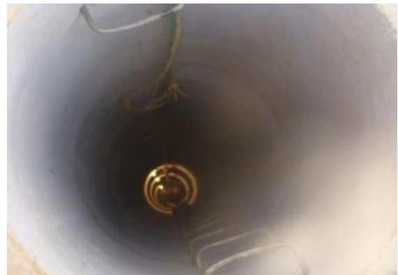
图 19 集水井井下检修
