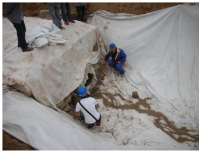
图 16 排水系统永久防护
