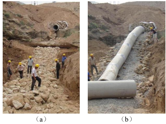
图 13 基岩陡坎处盲沟铺设现场施工
