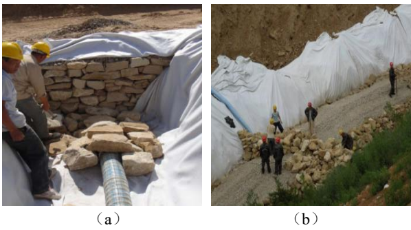
图 11 主、次盲沟连接现场施工图
