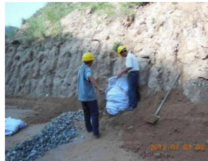
(b) 施工现场
