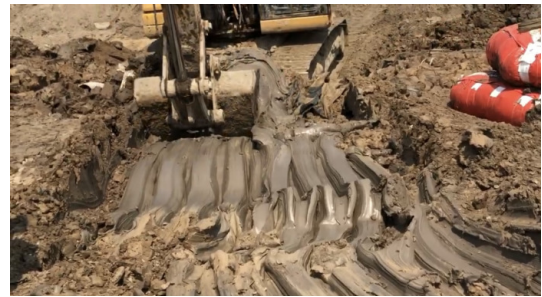
图 7 清理测点表面浮土 Fig. 7 Surface cleaning of test site
