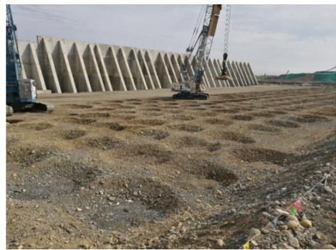
图7 分层振动碾压结合强夯补强工艺
