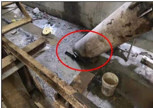
图5 反力架斜撑变形位移图
