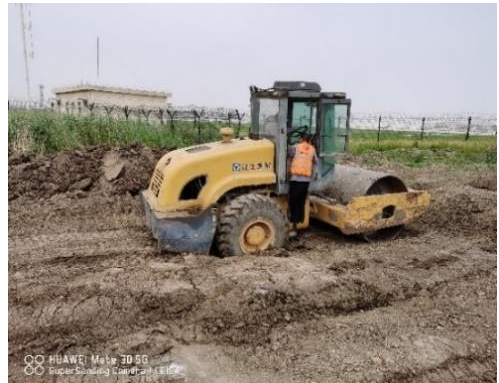
图1 现场碾压状况
