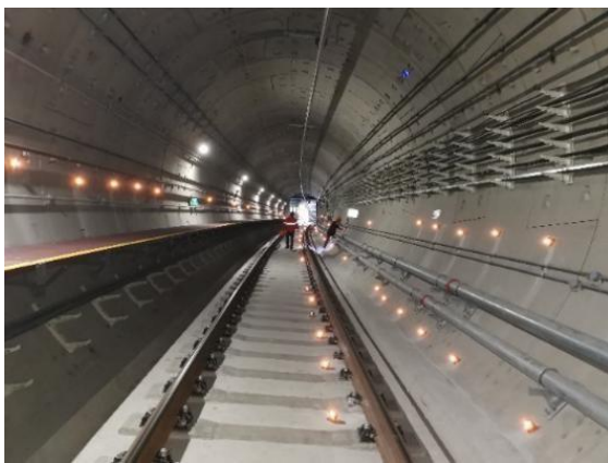
图 3 运营隧道变形自动监测
