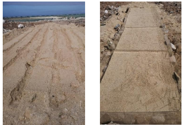
(a) 整平后的场地 (b) 加固区分隔
