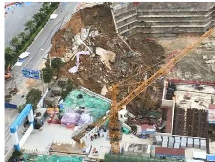
图2 基坑支护结构坍塌后情况
