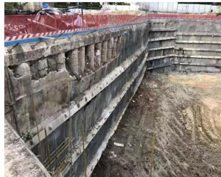
图1 坍塌前基坑支护结构情况
