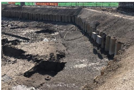
图 11 基坑围护结构完成后场景
