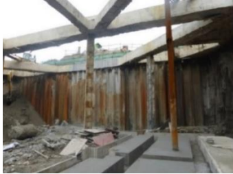
图4 武汉市某基坑支护工程实例
