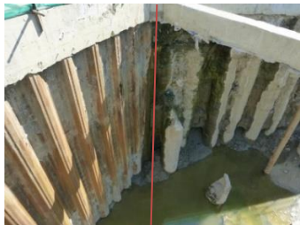
图5 挡土墙止水性比较
