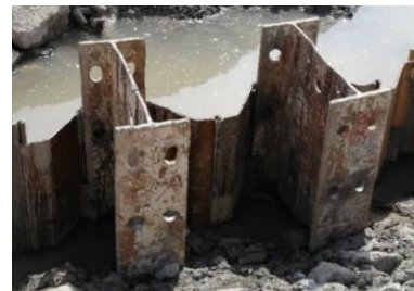
图 2 帽型 H 型钢嵌合型组合桩工程现场
