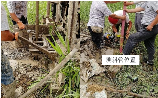
图3 安装测斜管示意图
