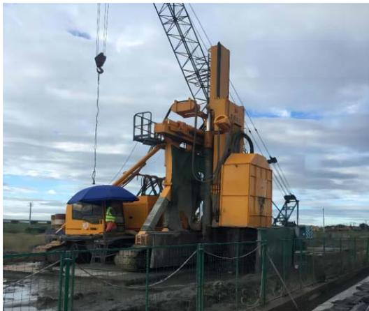
图 7 TRD 垂直防渗墙现场施工图
